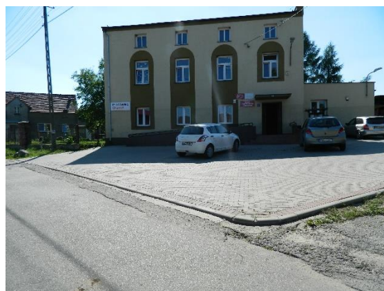
Rysunek 7. Budynek Gminnego Ośrodka Kultury i Gminnej Biblioteki Publicznej w Przedmościu (źródło: CDE Sp. z o.o.)
