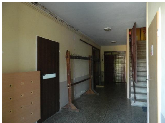
Rysunek 9. Wnętrze budynku GOK (źródło: CDE Sp. z o.o.)
